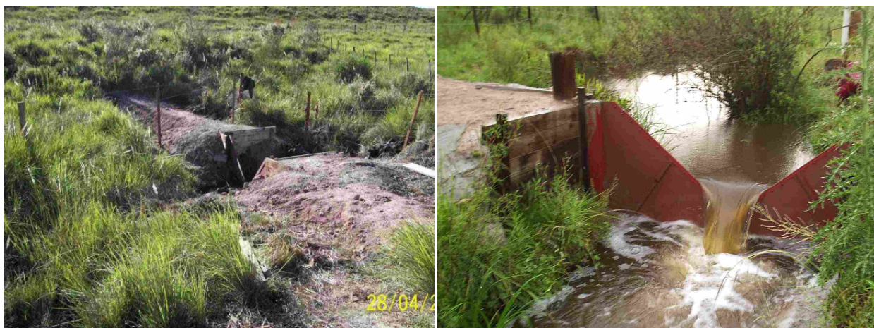
Figura 3.10 Vertederos y obras de cierre a la salida de las microcuencas
