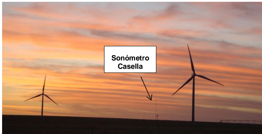
Figura 9.4. Parque Eólico Kentilux S.A.
