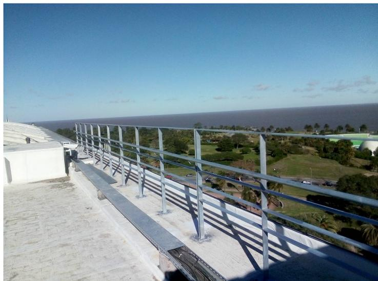
En el caso de las barandas de la azotea del Cuerpo Central se logró realizar la sustitución de las precarias existentes desde la construcción del edificio hace décadas y que no brindaban las condiciones de seguridad mínimas para el desarrollo tanto de los trabajos de mantenimiento, así como de los grupos de investigación que cuentan con equipamiento en dicho espacio.
