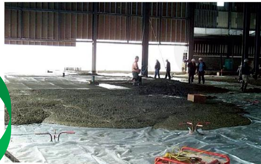
Losas sobre pilotes (suelos malos)
