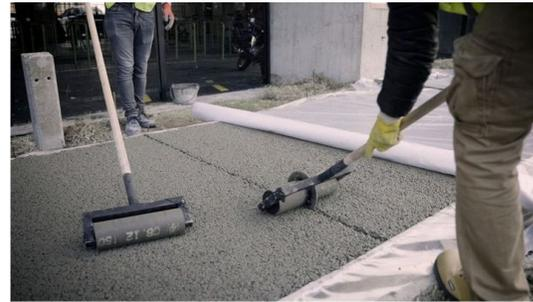
El hormigón permeable es un hormigón especial que se caracteriza por permitir el pasaje del agua debido al bajo porcentaje de poros interconectados que posee.
