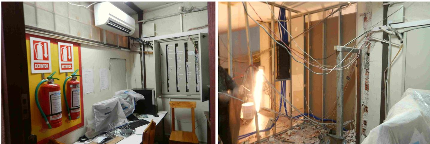
Además se realiza la adecuación de las instalaciones eléctricas, de redes de datos e iluminación. A los efectos de la demolición se retiró un equipo de aire acondicionado, el cual ya se volvió a colocar. También se instalaron los extintores y otros equipos retirados por las obras.
