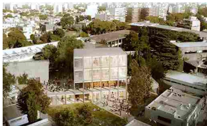
*El volumen de las aulas se eleva sobre el nivel de planta baja de del edificio actual, extendiéndose a modo de balcón, y se alinea con la geometría del edificio histórico, respetando el patio Carré y el patio central, que funcionan como vínculos físicos y visuales. La resolución formal propone la utilización de un lenguaje claramente contemporáneo, que no compite con el edificio histórico, pero que respeta sus lógicas y acompasa ritmos y alturas existentes.*
