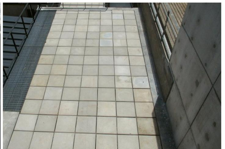
Se realiza además, por parte de la empresa Clemer S.A., trabajos varios de reparaciones: se sustituyeron algunos baldosones con fisuras en el sector de encasetonado, se fijó la placa de acero inoxidable en el Laboratorio de Construcción, se levantaron algunas de las observaciones relativas al Sistema de Protección contra Descargas Atmosféricas (SPDA), se colocó una cerradura, entre otros.
