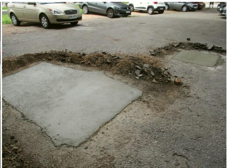
**Mantenimiento del piso del estacionamiento posterior.** Se realizó por parte de la empresa Constrac Ltda. trabajos de aporte de material y compactación del balastro del estacionamiento posterior.
