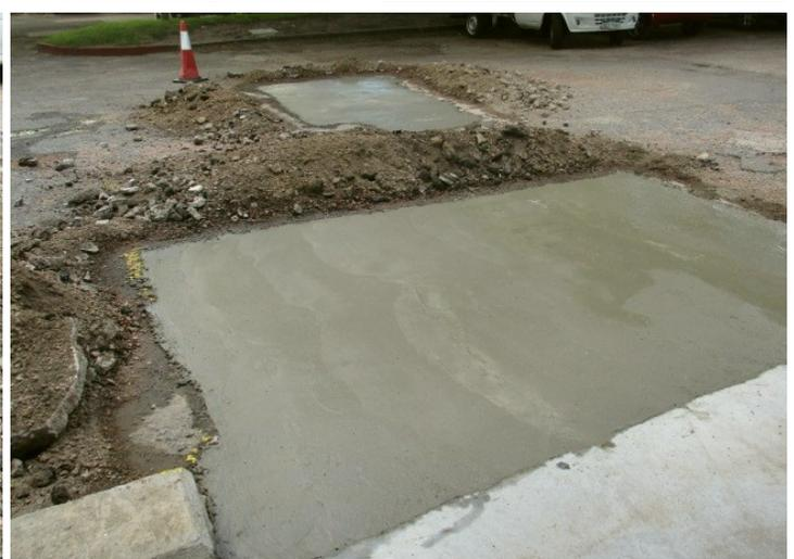
Los trabajos comprendieron la remoción del pavimento en el entorno de los baches, el compactado de la base, colocación de malla electrosoldada y posterior colocación de hormigón
