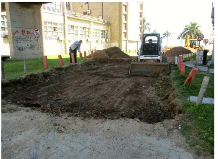
Para la colocación de los adoquines "besser" se retiró la capa existente de balasto para poder rellenar el terreno con tosca compactada. Sobre la base anterior se colocó un asiento con arena de 2 a 3 cm y sobre ésta se colocó el pavimento tipo "besser" rejuntado con arena suelta. El costo de este trabajos ascendió a \$ 117.535, impuestos incluidos más leyes sociales por un monto hasta \$ 34.000.
