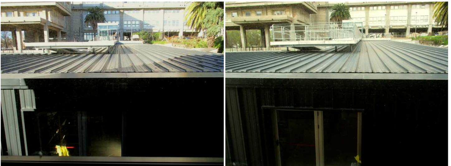
La estructura metálica se instaló completamente, se acondicionó el steel deck sobre el cual se construyó una losa en el sector de 2 niveles. También se instalaron los muros de Isopanel, el canalón, las chapas del techo y las que revisten las paredes. Antes de fin de año se realizó la adquisición del ascensor y del puente grúa con que cuenta el edificio, así como se realizó el acopio de varios elementos y materiales.
