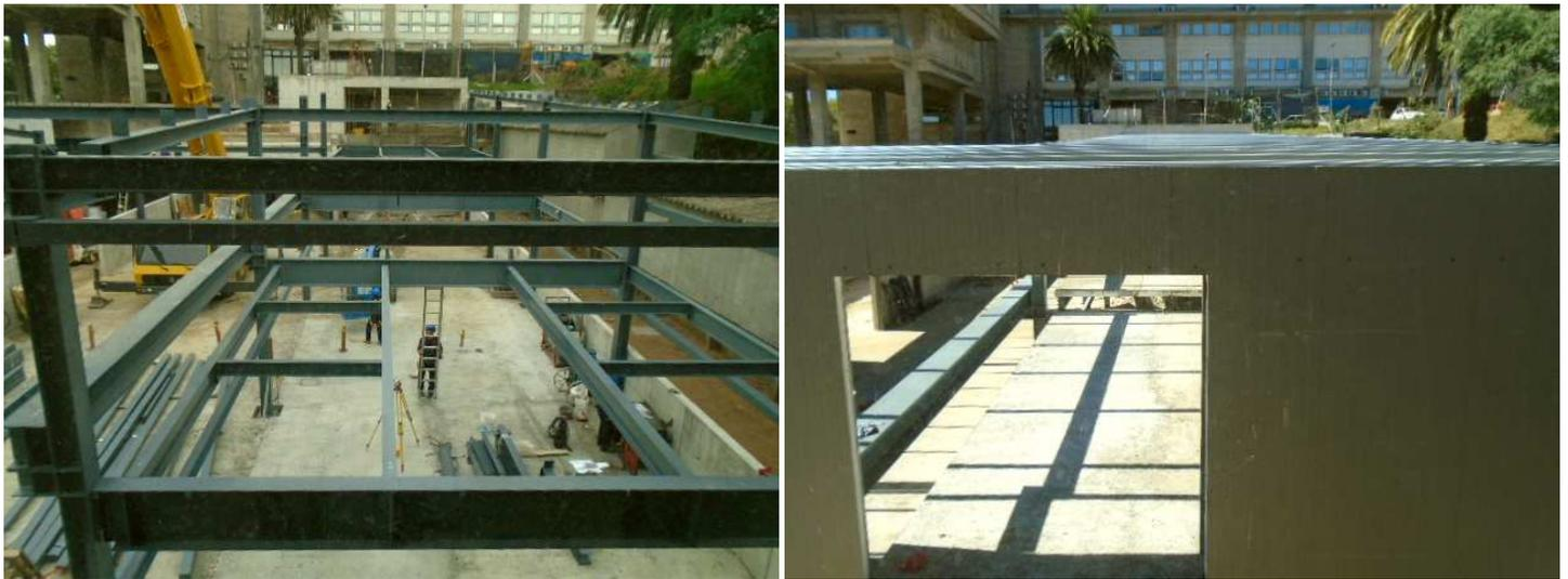
Luego se construyeron las fundaciones del edificio y se comenzó con los muros de contención. En paralelo se comenzó con la construcción de los pilares, vigas y losas de hormigón en el sector de servicios. Finalmente, antes de la licencia de la construcción, se terminaron los trabajos de hormigonado (salvo la construcción de escaleras interiores) de elementos estructurales y del contrapiso.
