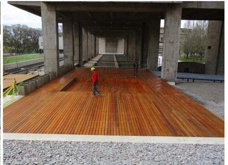
En el sector sobre la azótea de las oficinas del IMFIA en el 3er SS del Cuerpo Norte se encuentran también finalizados los trabajos de colocación del deck de madera. Previamente, en el sector donde se colocó césped, se instalaron losas de hormigón prefabricadas.
