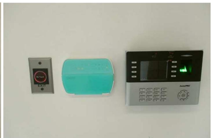
Como hemos mencionado el edificio cuenta con cámaras IP de vigilancia, sistema de seguridad contra intrusos, reloj para marca de entrada y salida del personal, sistema de control de accesos con tarjetas RFID (tanto para el edificio como para el ascensor), Sistema de Detección y Alarma de Incendio, telefonía IP, Sistema de Bocas de Incendio Equipadas (BIE) y un puente grúa de 10 toneladas entre otros equipamientos.
