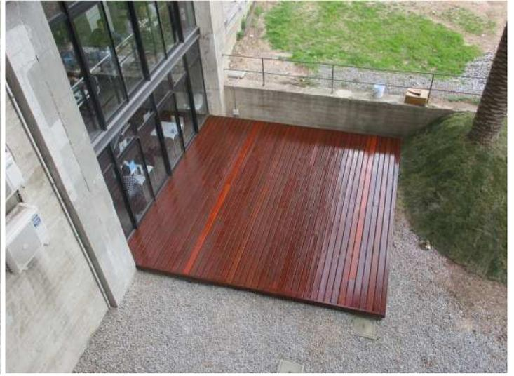
Se sustituyeron las tablas con deterioro, se procedió a la limpieza debajo del deck y al tendido de la canalización de luminarias. Posteriormente se aplicaron 2 manos de protector de madera.
