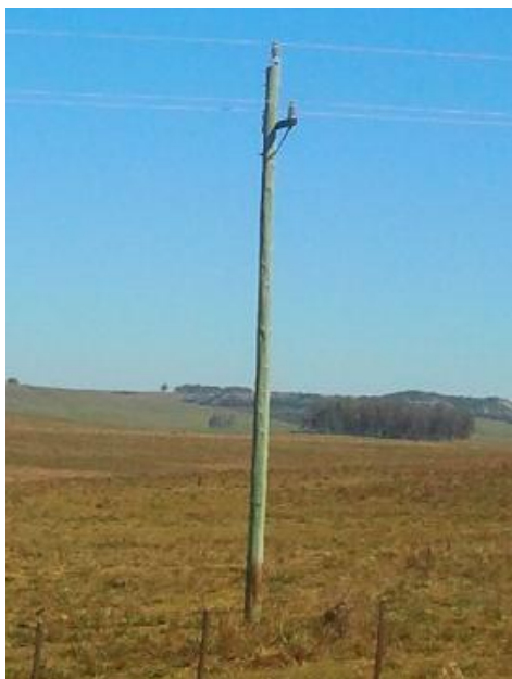
Figura 2. Postes de E. grandis impregnados en albura en Uruguay
